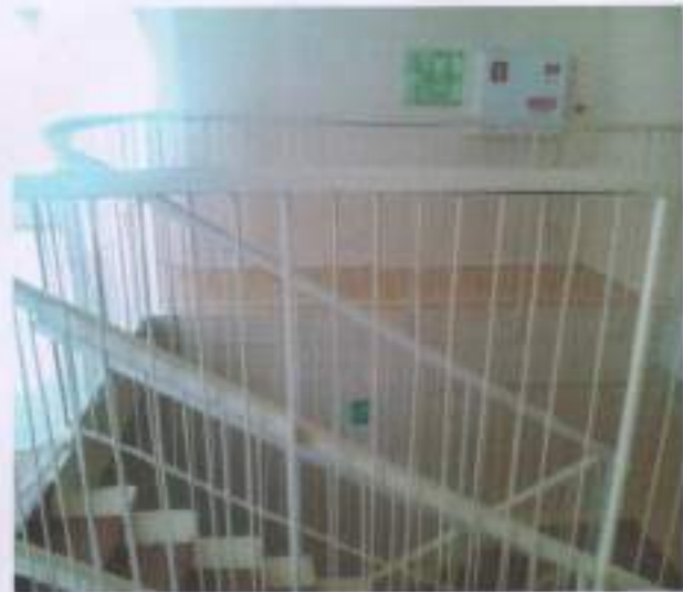
Фото № 16 Лестница на 2 этаж (правое крыло)
