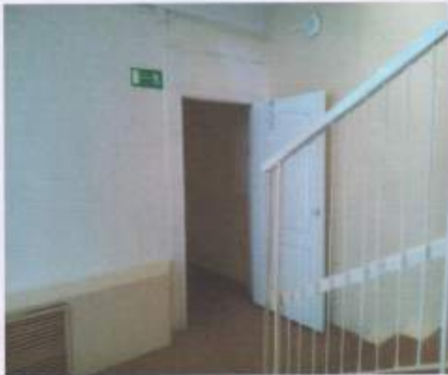
Фото № 15 Лестница на 2 этаж (правое крыло)
