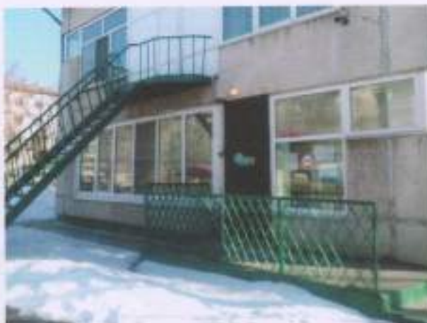
Фото № 9 Вход в здание (в группу) ДООУ, 1 этаж
