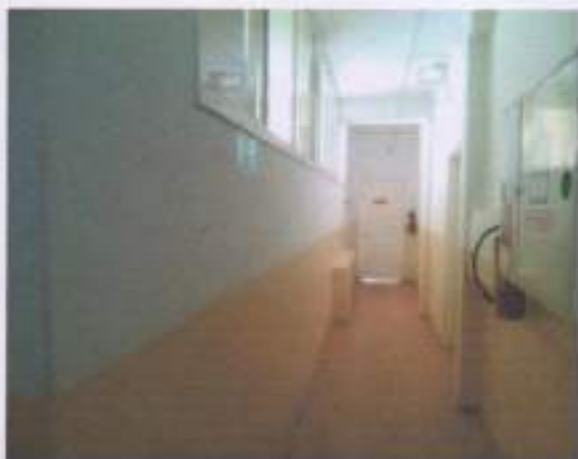
Фото № 21 Коридор (путь эвакуации)
