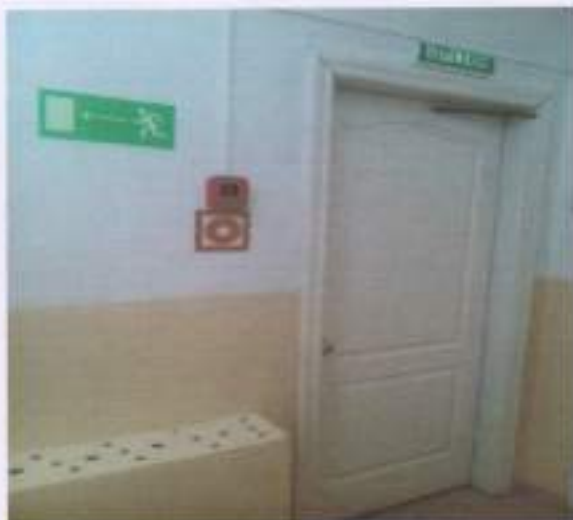
Фото № 17 Эвакуационный выход 1 этаж (левое крыло)
