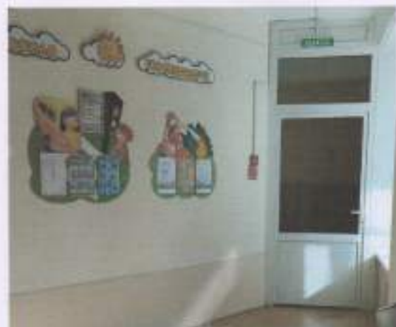
Фото № 18 Эвакуационный выход 1 этаж (правое крыло)
