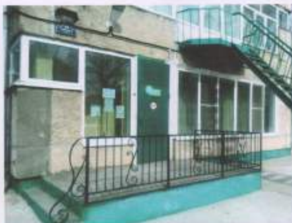
Фото № 10 Вход в здание (в группу) ДООУ, 1 этаж
